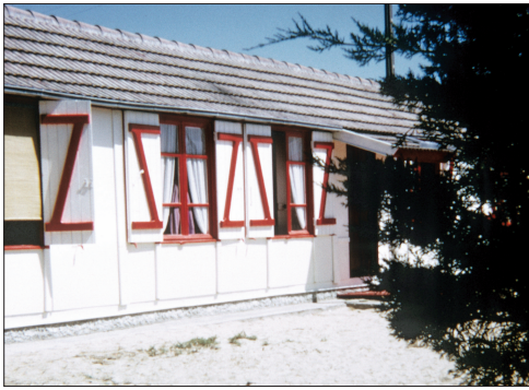
FIG. 11. — Île de Noirmoutier, Barbâtre, hameau de La Fosse. La façade du gîte loué par Monsieur ALBERT, 43, Allée de la Chapelle. On distingue sur la droite du cliché l'auvent sous lequel nous avons suspendu la lampe à vapeur de mercure, sage précaution permettant d'éviter l'explosion de la lampe en cas d'irruption d'une averse inattendue. Sise en lisière d'un clair-bois de Pins maritimes, la longère occupait un endroit idéal pour effectuer des prospections nocturnes, offrant en outre l'avantage, grâce à sa façade peinte en blanc, de réverbérer l'éclairage de notre dispositif lumineux. 4 juillet 1970. Cliché : © Nelly-Claude LUQUET. Numérisation de la diapositive : Alain DAHMANE.
